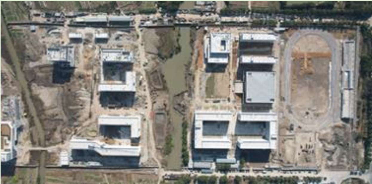
鄞州职高施工现场，来源：宁波城建投资集团有限公司 2024 年社会责任报告
