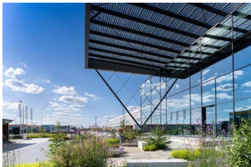
图 10：埃因霍温 DC4 项目局部光伏系统
