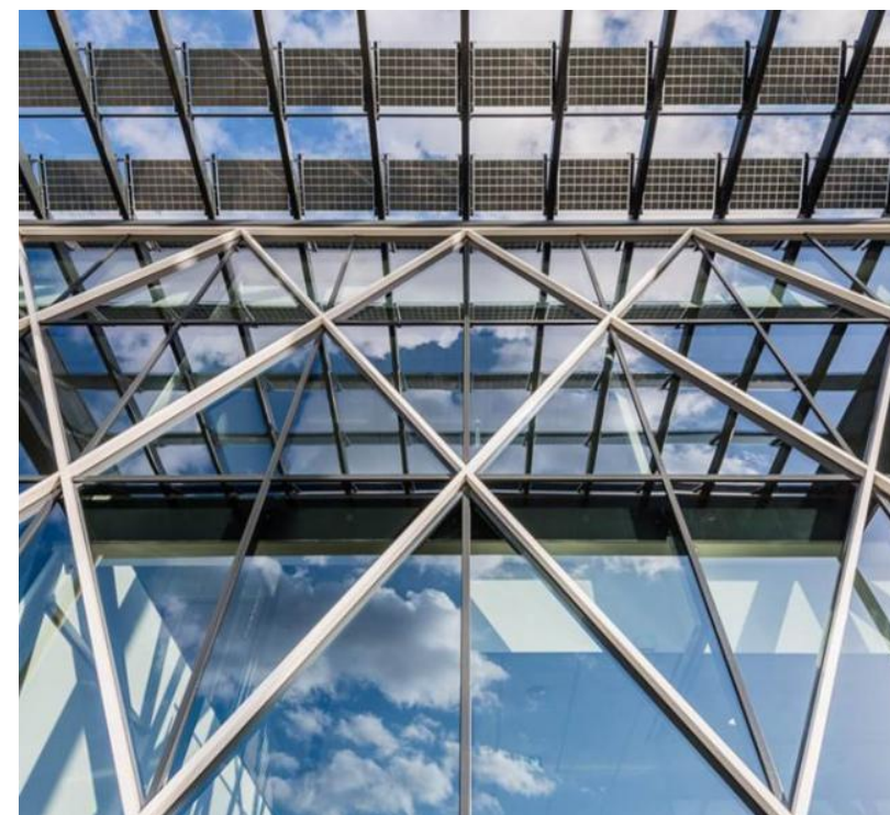
图 9：埃因霍温 DC4 项目屋顶及建筑饰面材料
