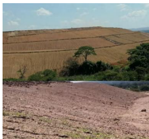
图 8：2024 年 KFM 矿区对排土场边坡复垦后
