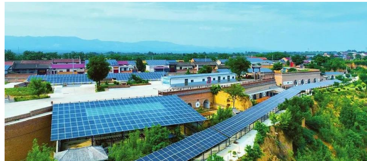
图 10：庄上村“光储直柔”能源系统
