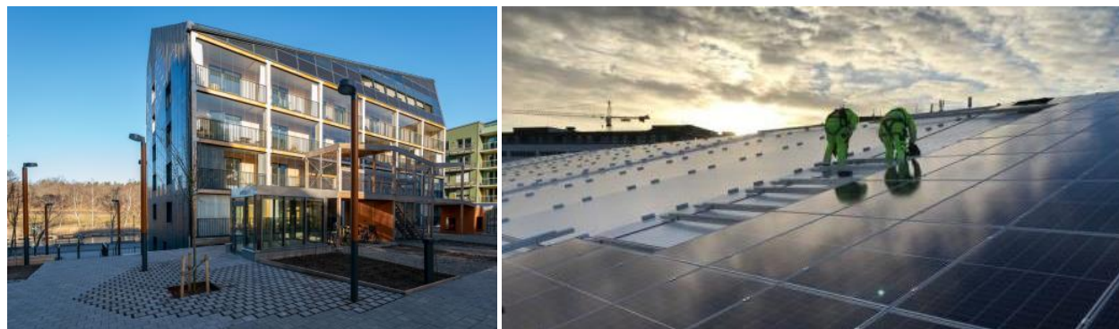
图 3：设计师将建筑物的屋脊旋转，更高效地捕捉太阳光 图 4：集成整合中心屋顶的太阳能电池板
