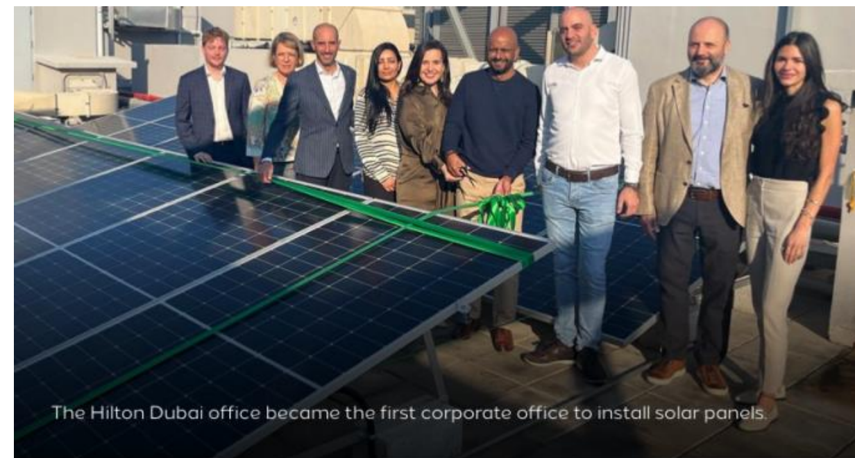
图 7：太阳能光伏发电设施
