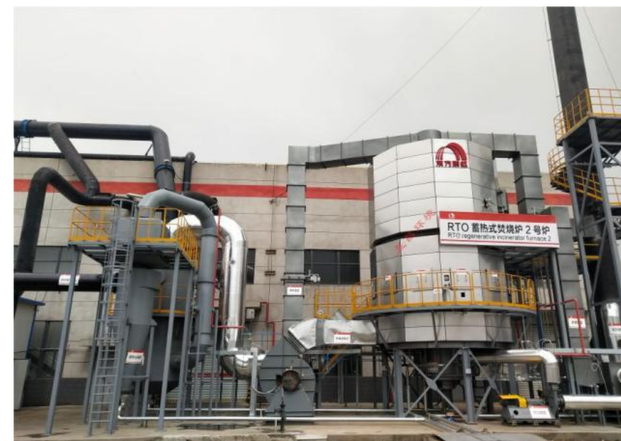
图 15：东方雨虹 RTO 旋转式烟气处理设备示意
