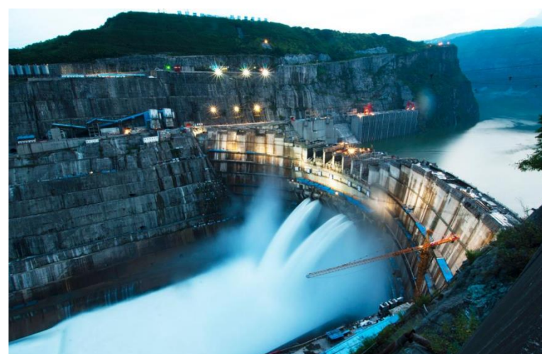
图 11: 溪洛渡水电站
